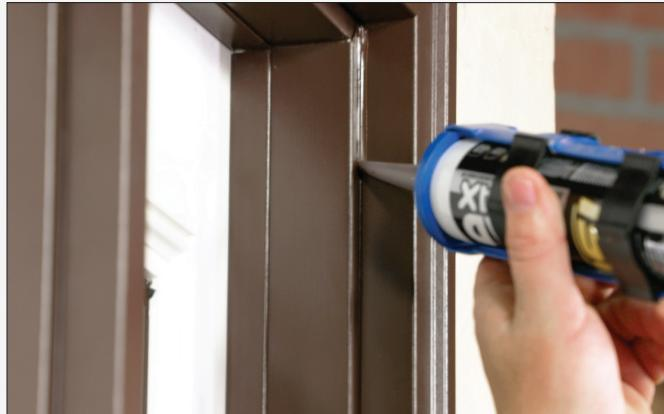
**B.** Repita el paso **A** para la otra cubierta de la jamba, la cubierta del perfil superior y donde las cubiertas de la carcasa del poste de soporte coinciden con las de la jamba del poste de soporte.
