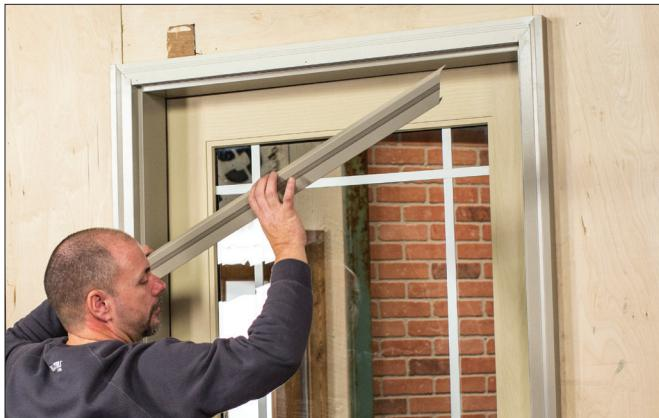
**B.** Retire las cubiertas de los perfiles izquierdo y derecho.
