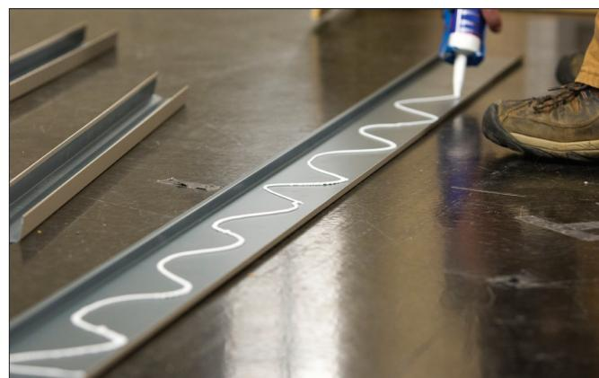
**B.** Comenzando en la parte superior de la unidad, suavemente levante la cubierta de la jamba detrás del burlete moviéndose hacia abajo hacia la parte inferior de la unidad. Finalmente, presione la cubierta de la jamba contra la jamba de la puerta a lo largo de la longitud para asegurar que el adhesivo se adhiera a la pata de la jamba. Repita por el otro lado.
