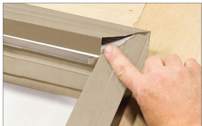
**C.** Aplique presión a lo largo de la cubierta del perfil superior para garantizar que el adhesivo se adhiera al perfil.
