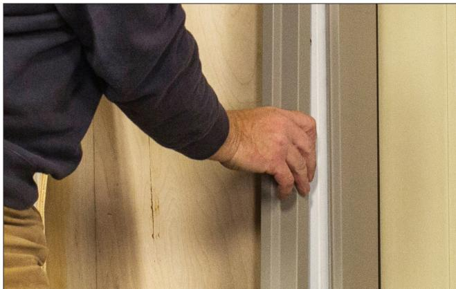
**C.** Abra la puerta y retire la cubierta de la jamba de la puerta tirando de la parte inferior desde detrás del burlete hacia el centro de la puerta, trabajando hacia la parte superior de la unidad. Repita por el otro lado.
